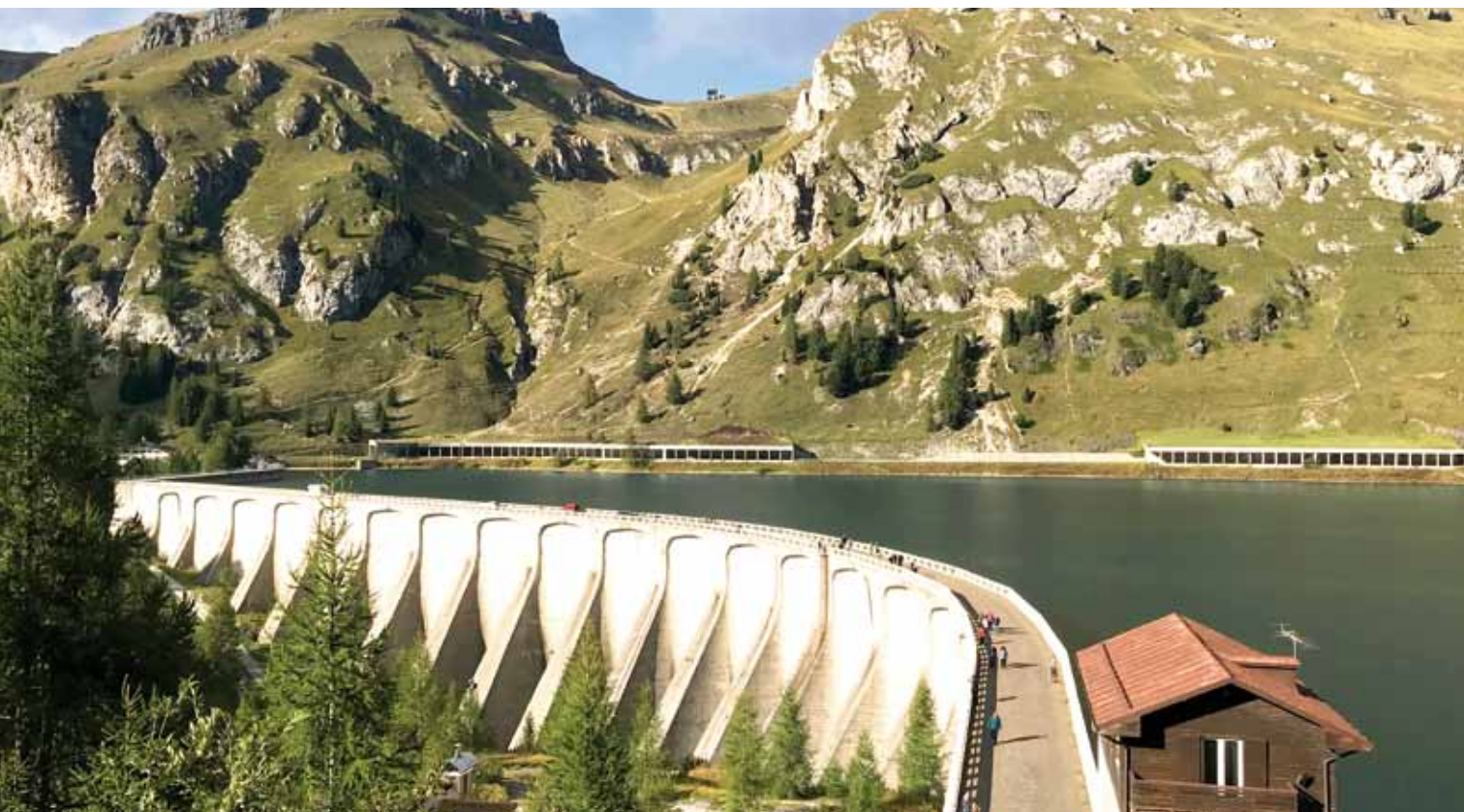
▲ La diga del lago di Fedaia
